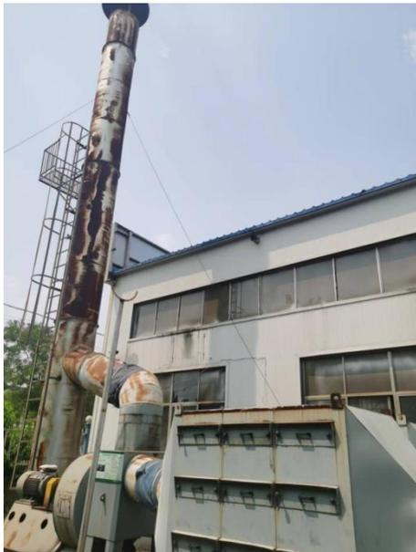
喷漆废气处理设施及排气筒（4#）
