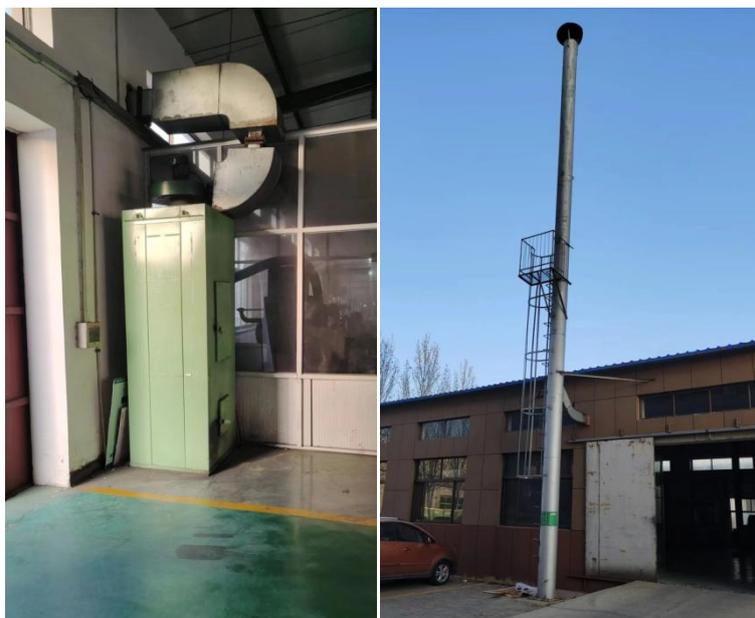
磨削废气处理设施及排气筒（8#）
