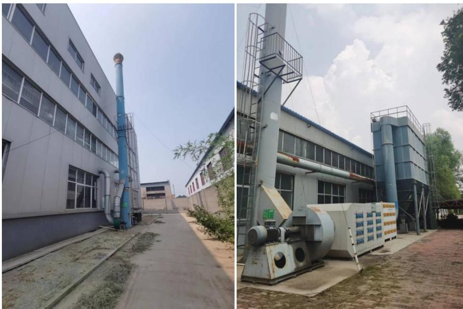
混料间废气处理设施及排气筒（1#）
