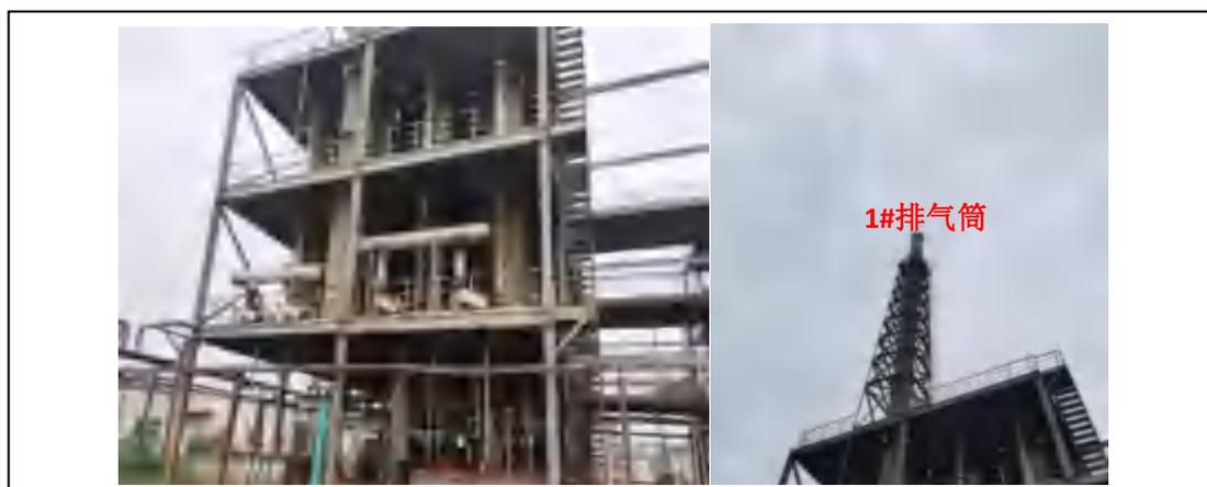
图 4-1 尾破装置及排气筒
